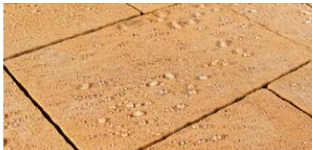
POVRCH DLAŽBY S ÚPRAVOU DEP
