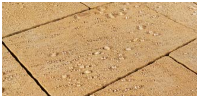
POVRCH DLAŽBY S ÚPRAVOU DEP
